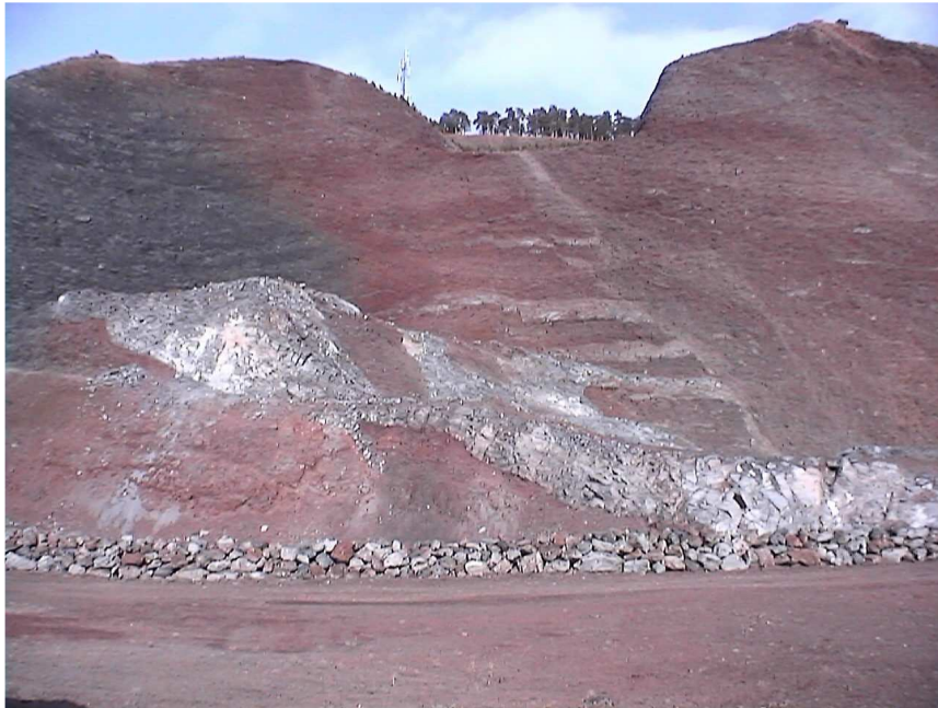
Photographie montrant les mouvements de terrain.
